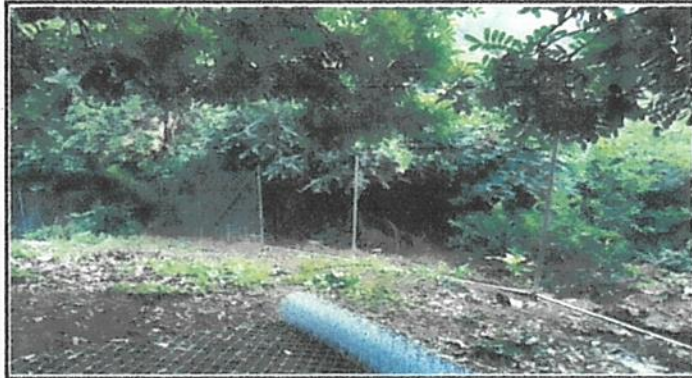
Foto 3: Instalación de malla perimetral
