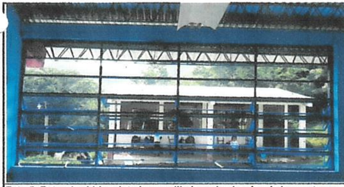
Foto 5: Retro de vidrio, pintado y cepillado en los bordes de las ventanas
