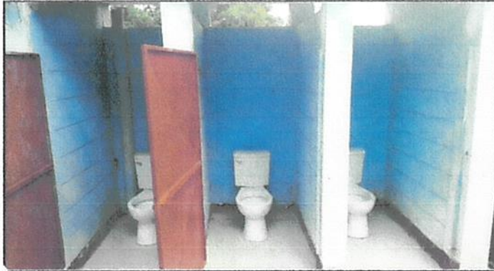
Foto 1: Instalación de los sanitarios y plancha de concreto en el interior.
