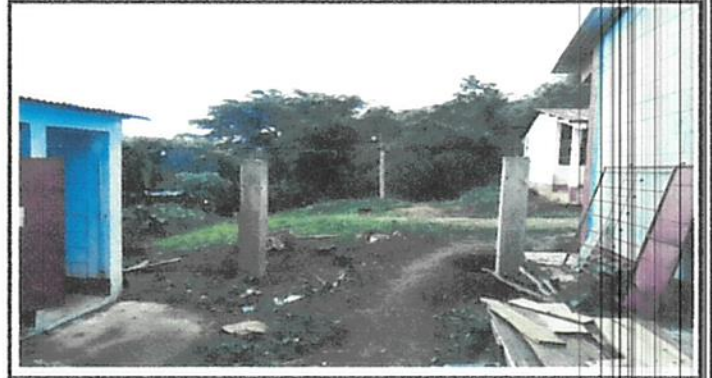
Foto 4: Simiento de columnas para la instalación del para instalar en portón.
